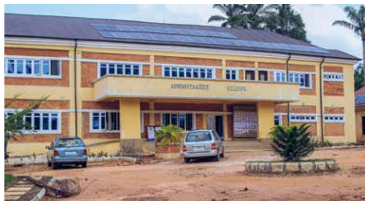
Verwaltungsgebäude: Beherbergt die wesentlichen Verwaltungsbüros und provisorischen Lehrräume für die Vorlesungen
